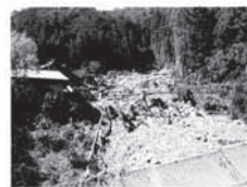
旧宮川村の被害(平成16年)
