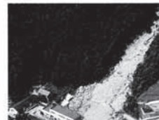
紀伊半島大水害の被害
